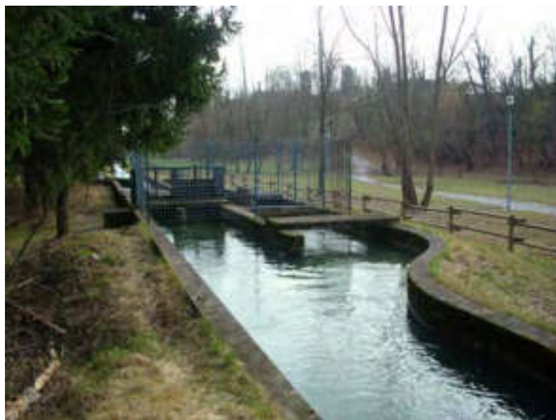
Figura 14 - Manufatto partitore sul canale del Cosa
