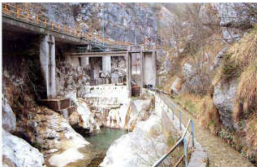
Figura 15 - Opera di presa sul Colvera
