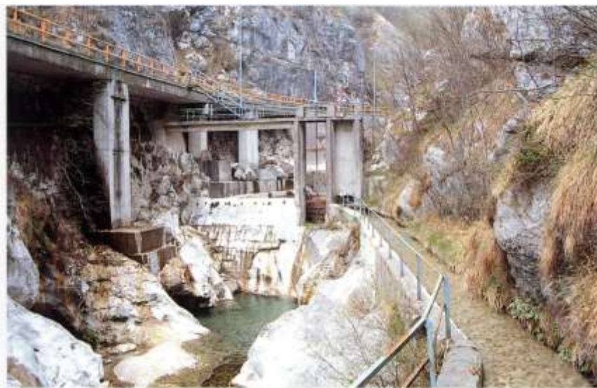
Figura 3 - Opera di presa sul Colvera
