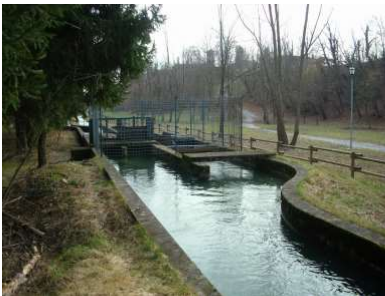
Figura 2 - Manufatto partitore sul canale del Cosa
