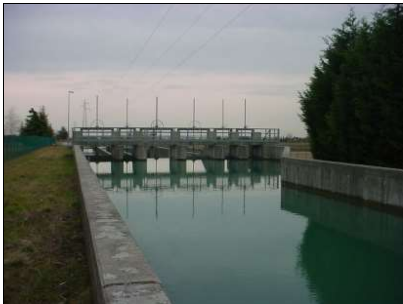
Figura 9 - Manufatti partitori alla presa del Giulio
