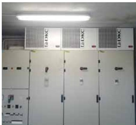
pianto. Infine è stata climatizzata la sala quadri e comandi per garantire il funzionamento ottimale delle apparecchiature elettriche ed elettroniche. L'impianto era entrato in avaria alla fine della scorsa stagione irrigua.
