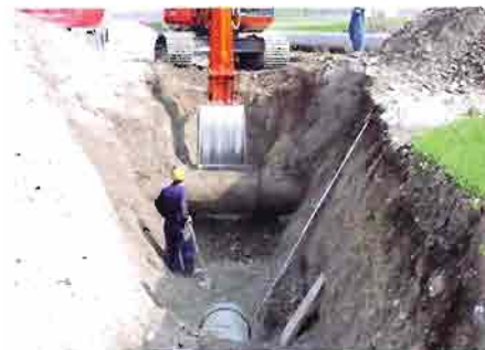
Lavori di conversione irrigua
