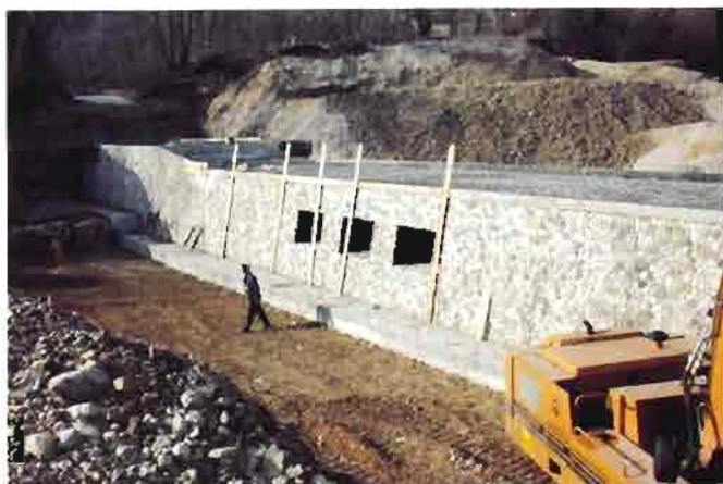
Briglia - ponte su un torrente pedemontano
