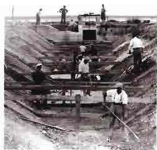
Le basi di scavo e di modanatura del canale Brentella di Villa Rinaldi
