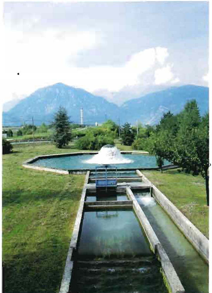
Nodo idraulico - ponte Giulio - con valenza ambientale
